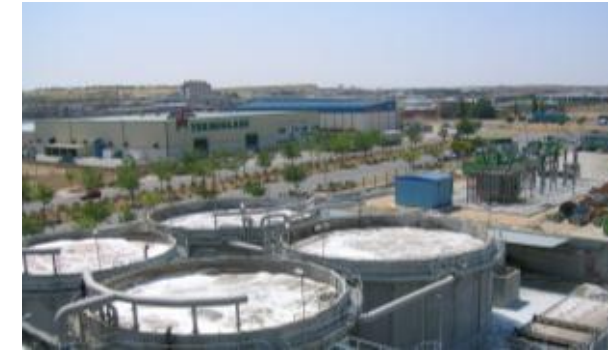
System FlooBed® MBBR wbudowany w okrągłe zbiorniki betonowe
