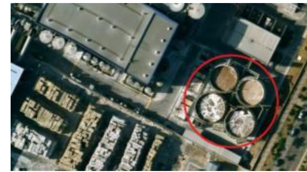
System MBBR o niewielkich gabarytach wbudowany w gęsto zabudowany teren przemysłowy
